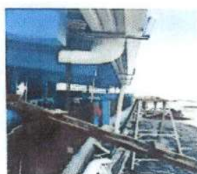
Foto 4: canales y bajadas de agua pluvial
