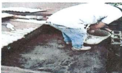
Foto 1: Impermeabilización de losa de los baños
